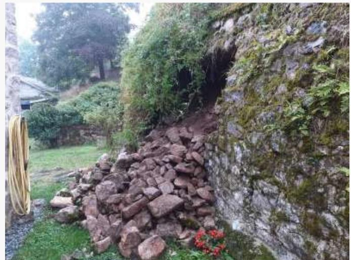
Suite aux intempéries du mois de septembre 2024 un pan du mur de soutènement de la route qui mène au Puech de Montcausson s'est effondré laissant apparaître un trou de 10 mètres de long sur 2,50 mètres de haut.
